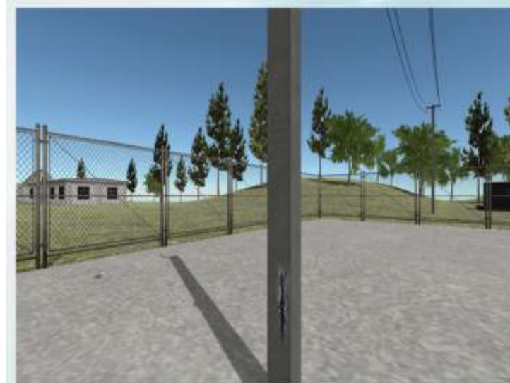
Недопустимо оголение арматуры железобетонных опор ВЛ ( \geq 1 м)
